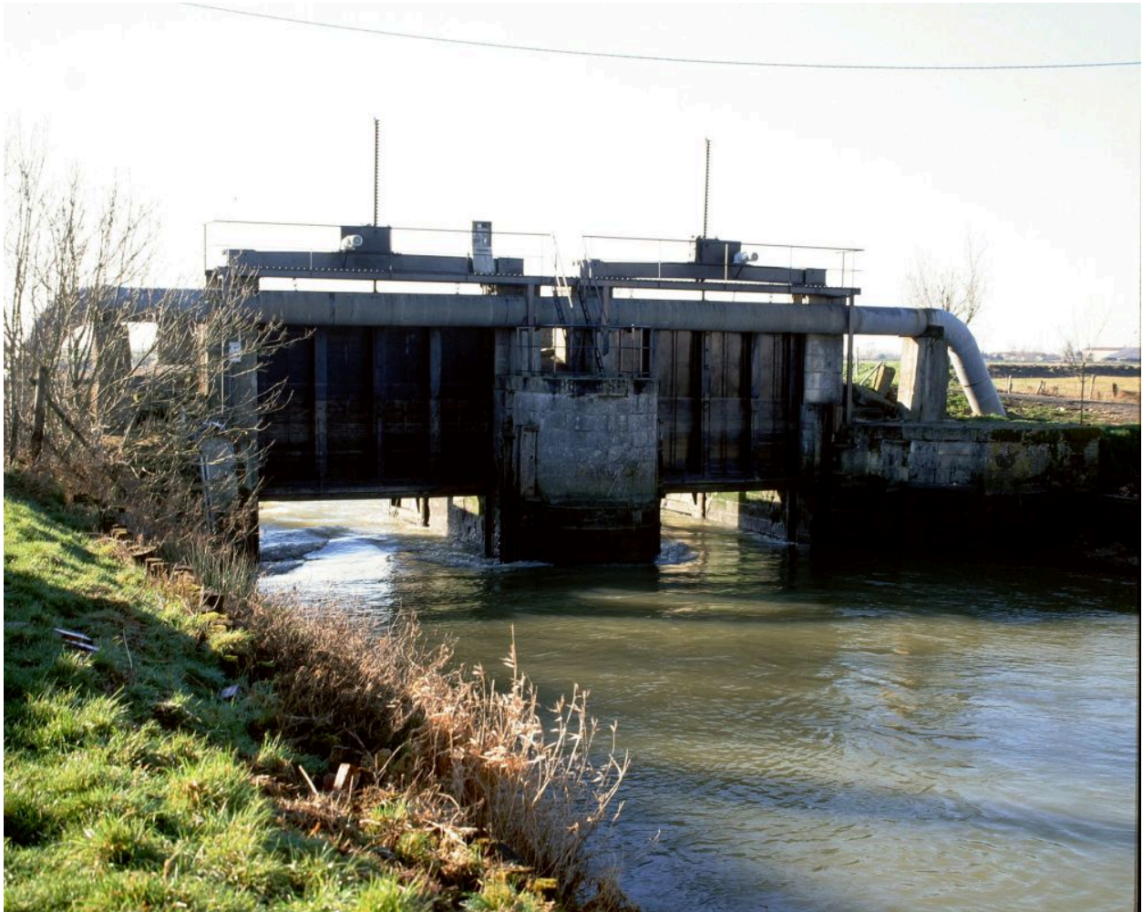
Les portes, ouvertes et vannes relevées, vues depuis l'amont.
