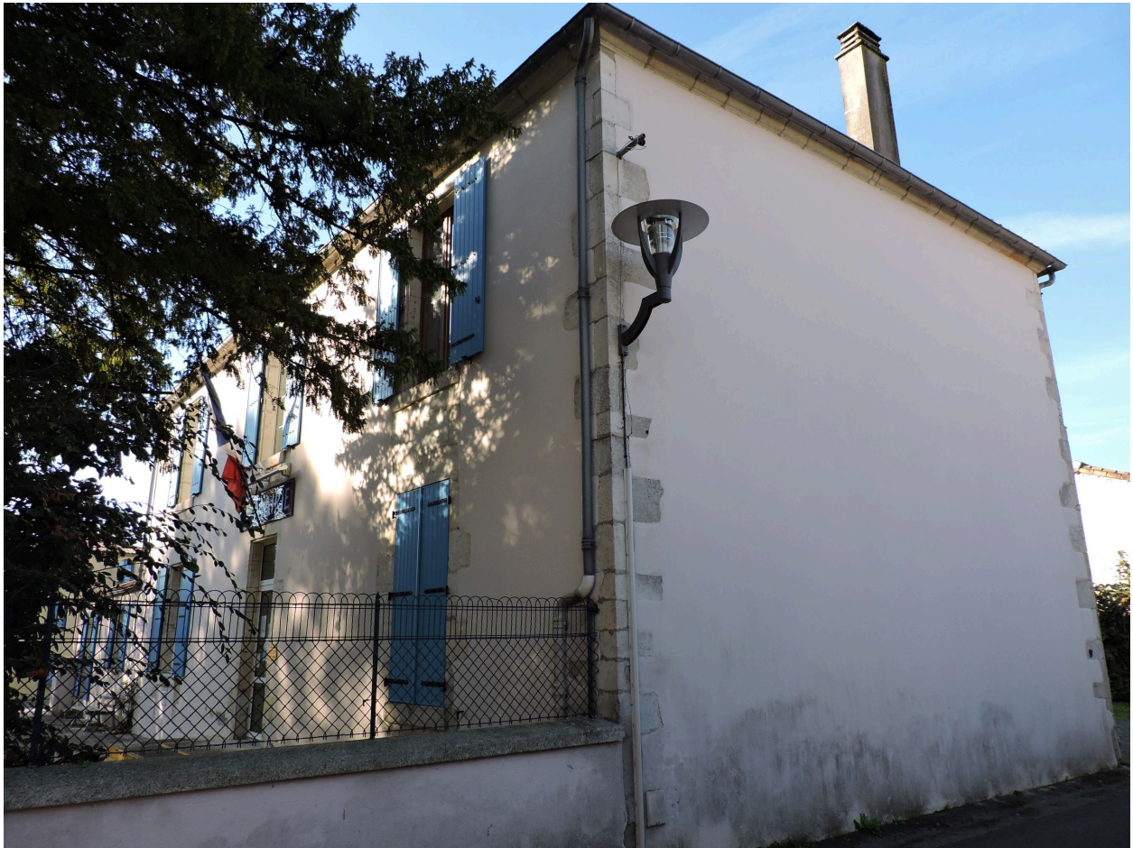
La mairie vue depuis le nord-est.
