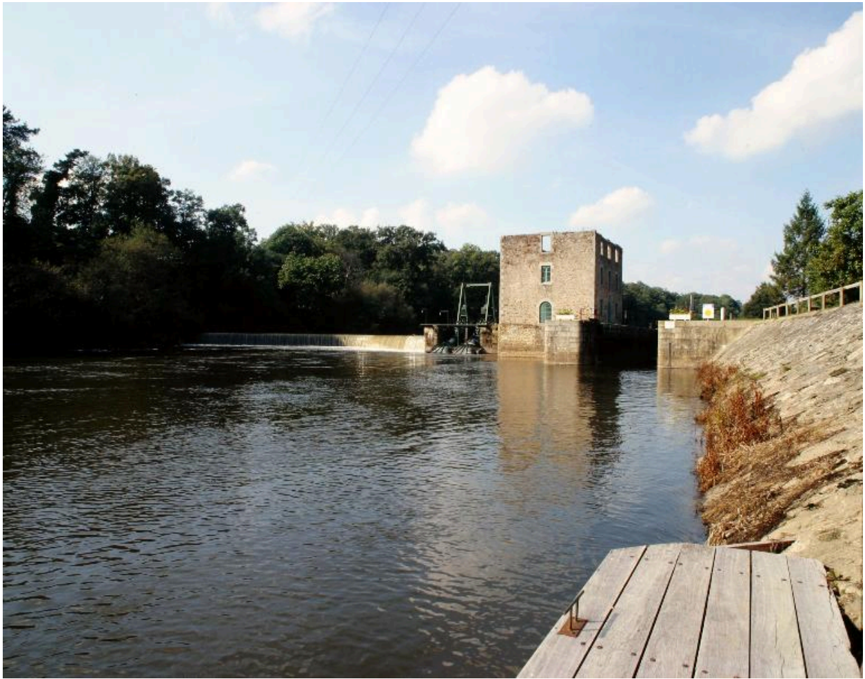
Vue d'ensemble du site d'écluse depuis le ponton situé en aval : barrage, usine hydroélectrique, moulin, écluse.
