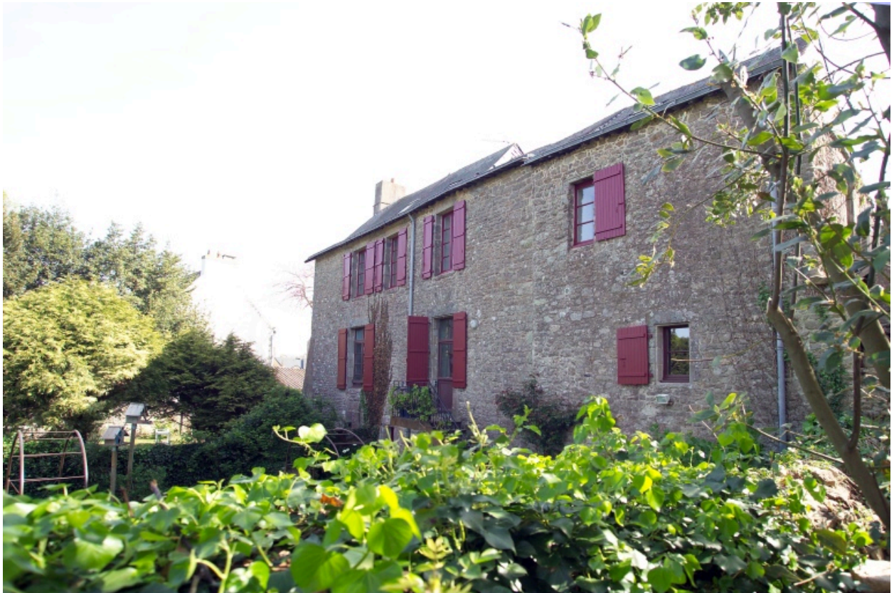
Vue de la façade arrière.
