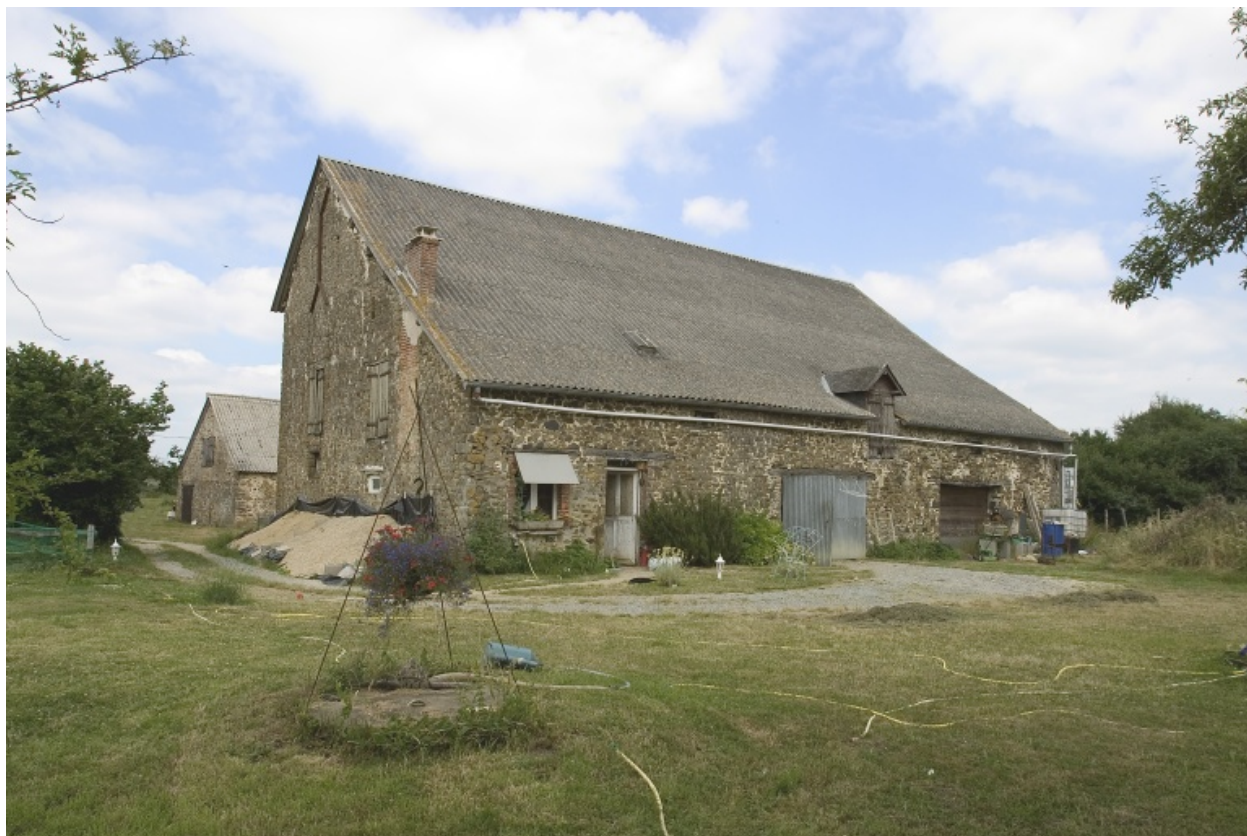
L'étable-grange : façade sud.
