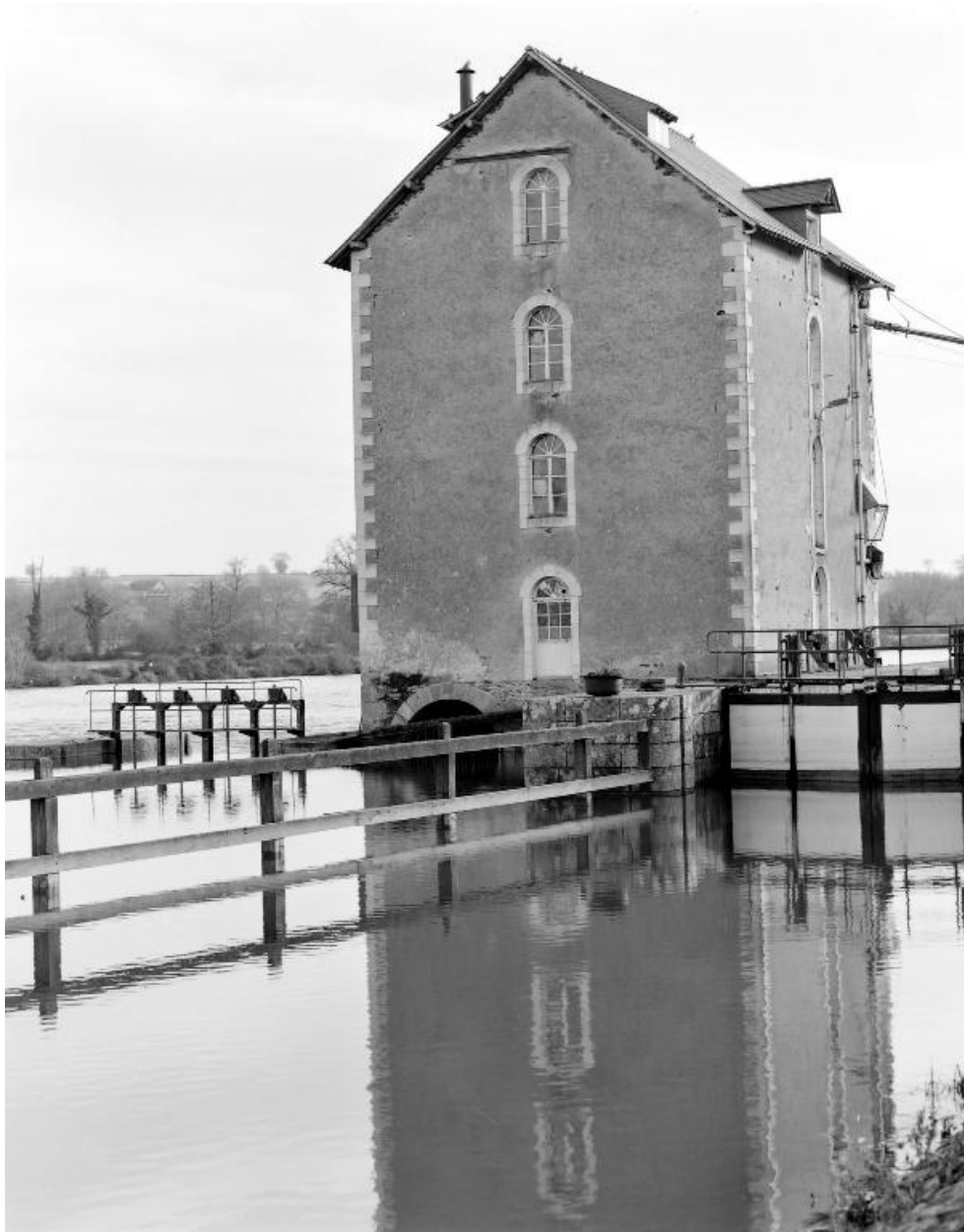
La façade nord du moulin, située en amont de la rivière, en 2002.
