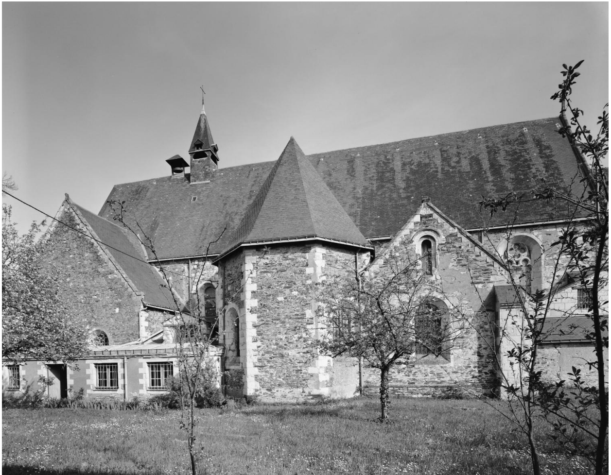
Eglise : l'élévation latérale gauche avec l'ensemble des sacristies et chapelles.
