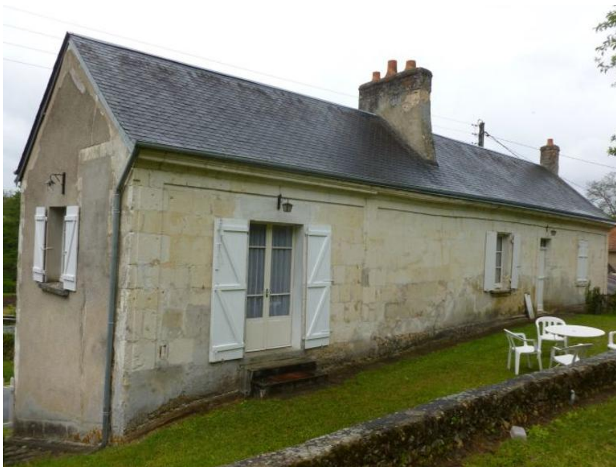
Maison, façade est : étage de plain-pied.
