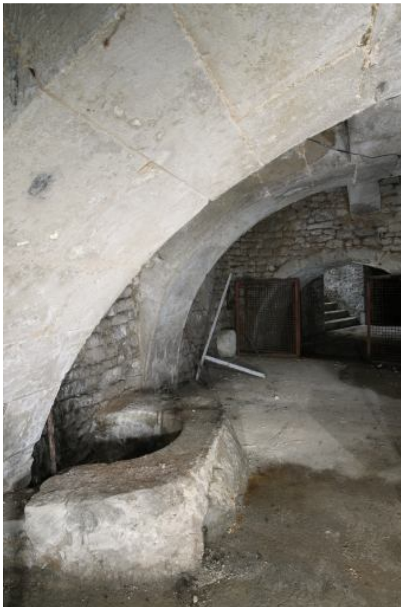
Sous-sol du bâtiment perpendiculaire à la chapelle.
