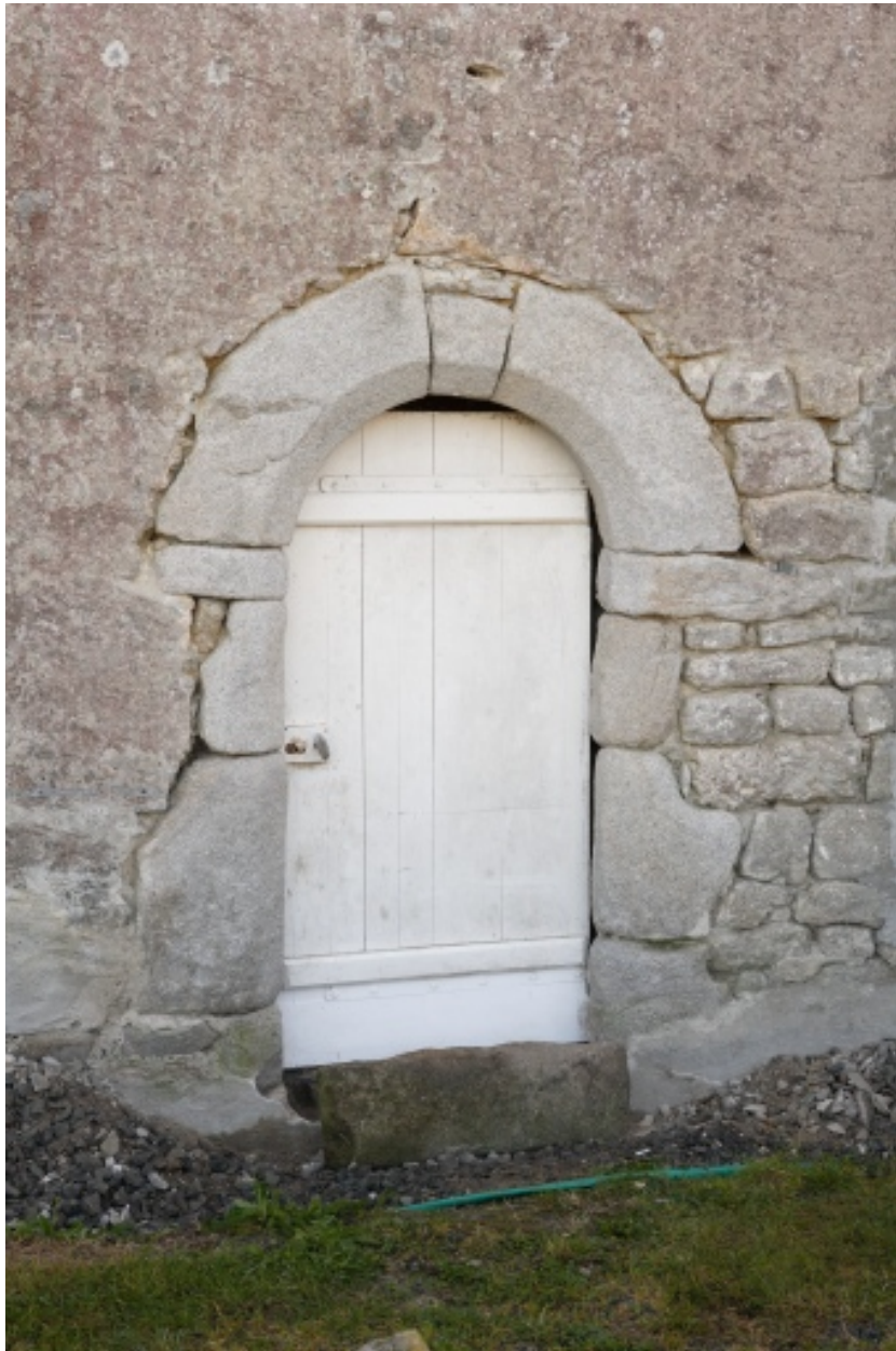
1er logis. Façade ouest. Porte.
