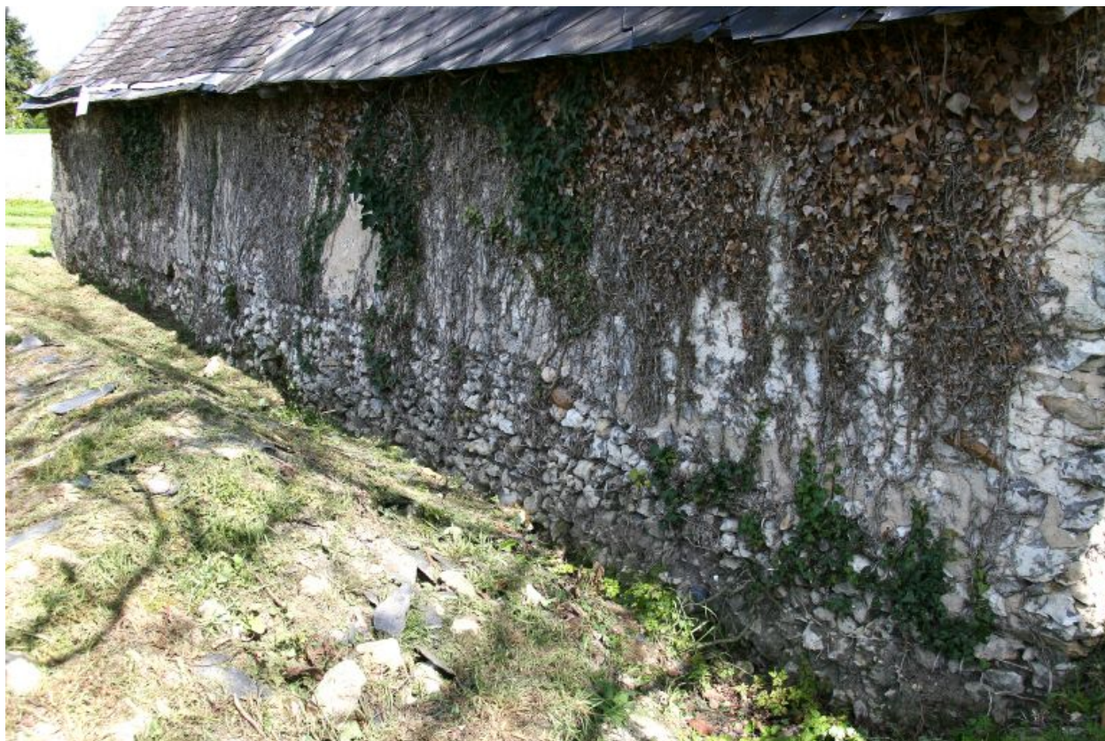
Maison 1, façade postérieure : mise en oeuvre des pierres.
