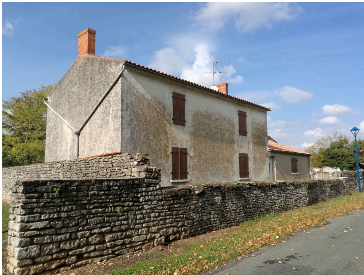
Maison à un étage, seconde moitié du 19e siècle, rue de la Cigogne.
