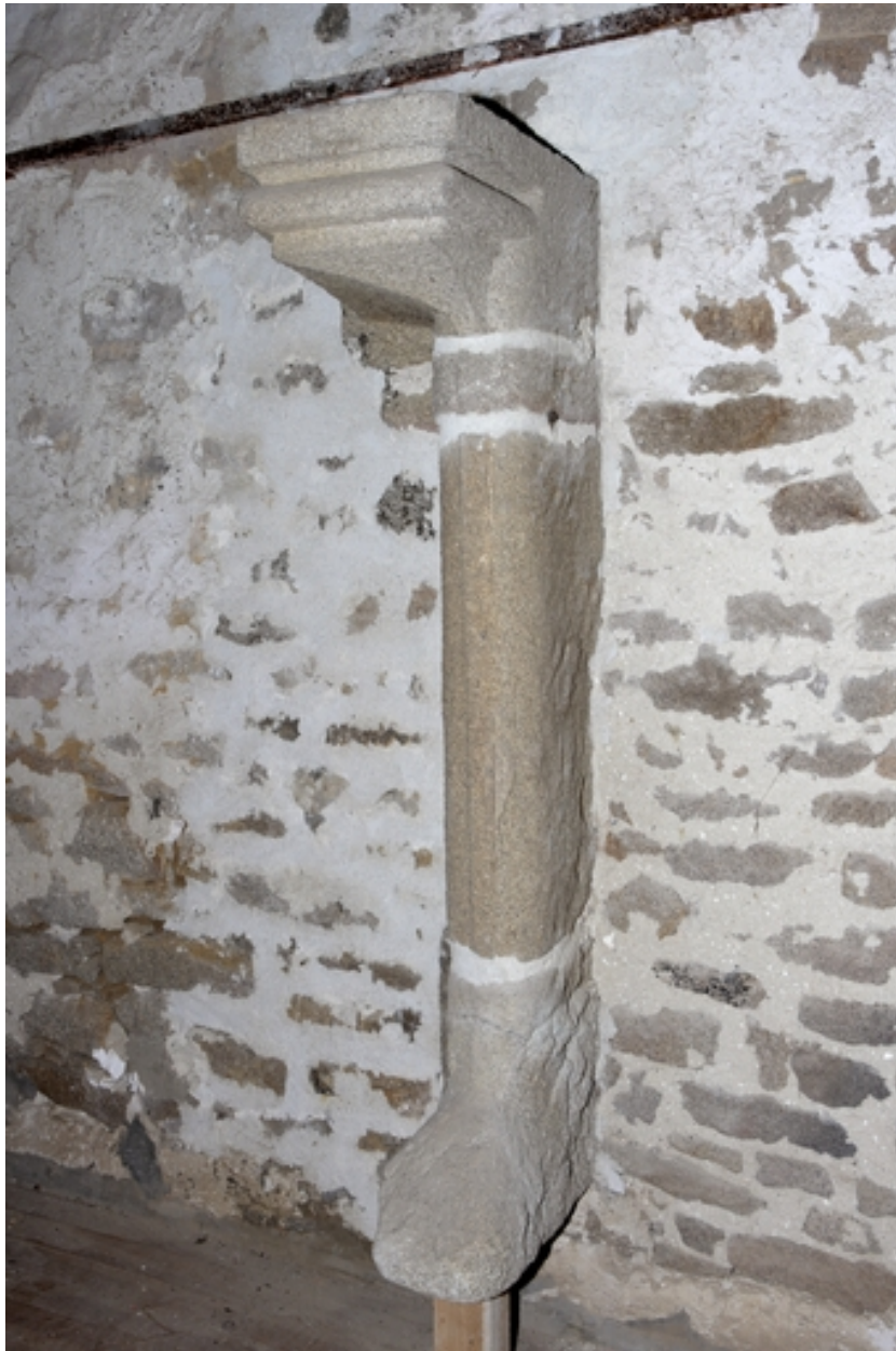
Premier étage. Chambre haute. Cheminée.
