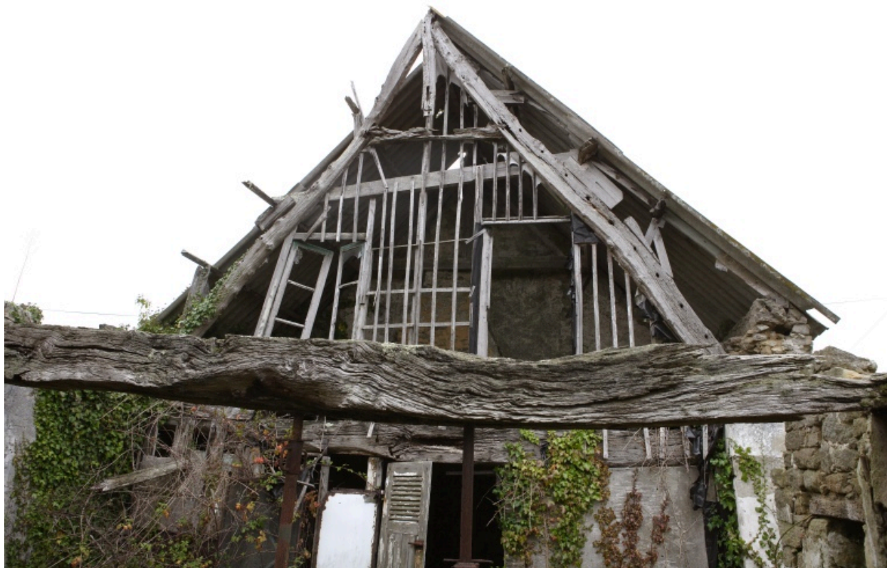
Détail de la charpente du logis est.
