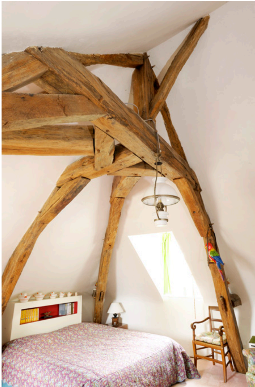
Charpente : détail de l'enrayure de la croupe est.
