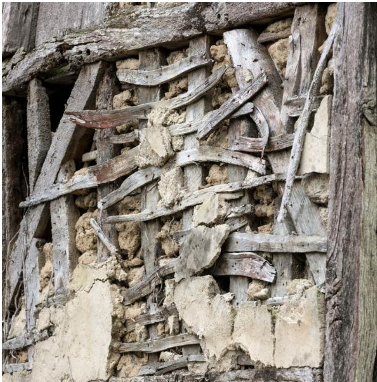
Mur en torchis et pan de bois, enduit de chaux, d'une remise, hameau de la Teillaie.
