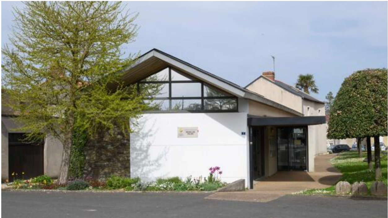
La mairie du Mesnil-en-Vallée. Vue depuis l'ouest.
