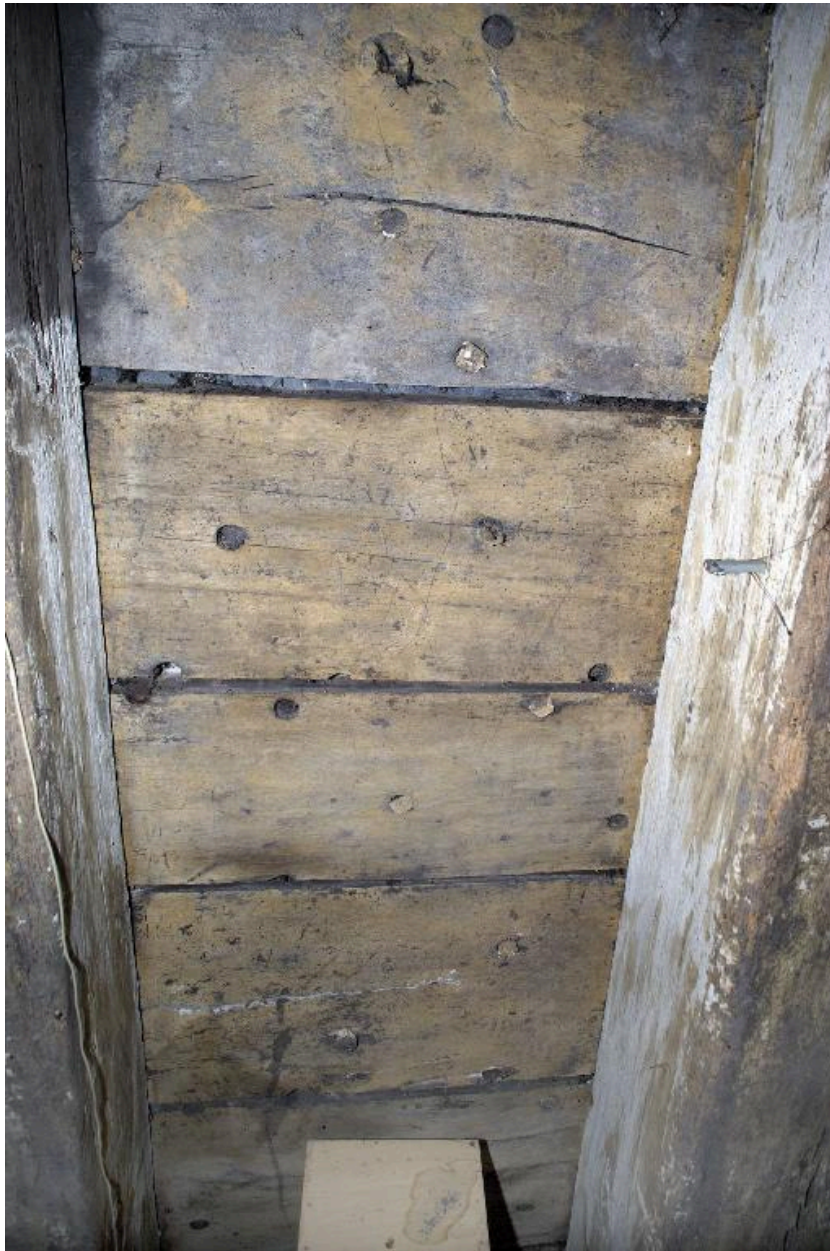
Le plancher du rez-de-chaussée vu depuis le niveau des caves, détail.
