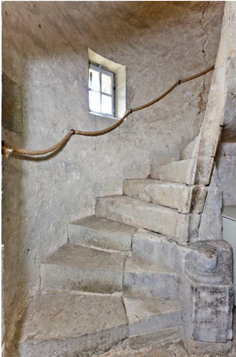
Vue de l'escalier en vis suspendu depuis le rez-de-chaussée.
