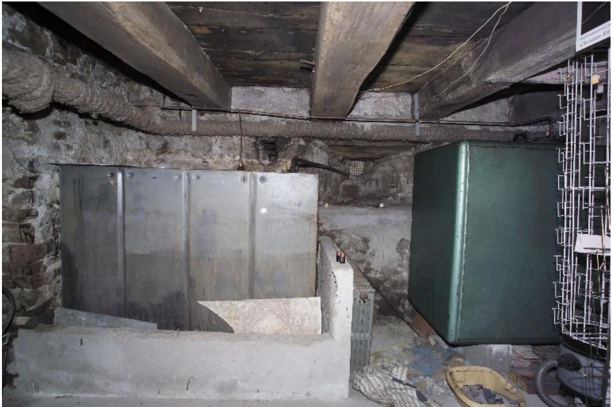
Le niveau des caves vue de l'escalier vers le quai.
