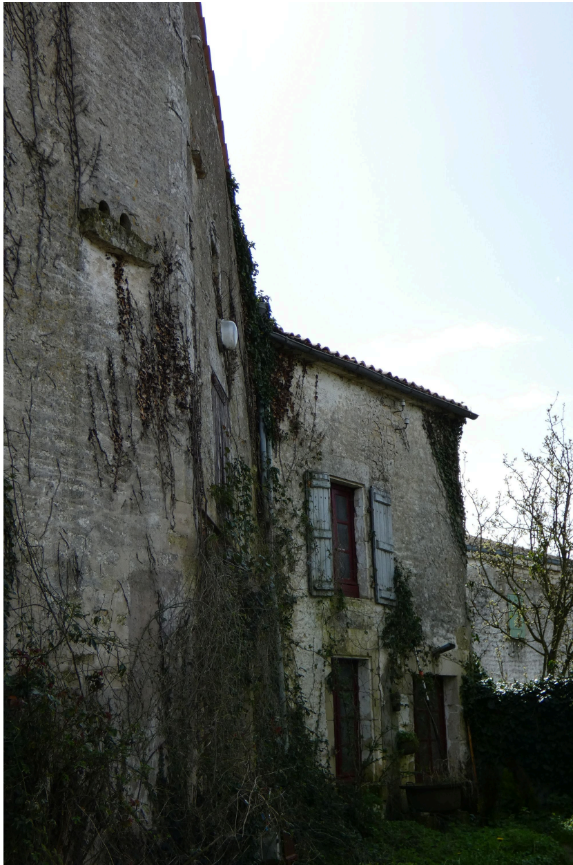
L'arrière de bâtiment avec une paire de boulins à pigeons.
