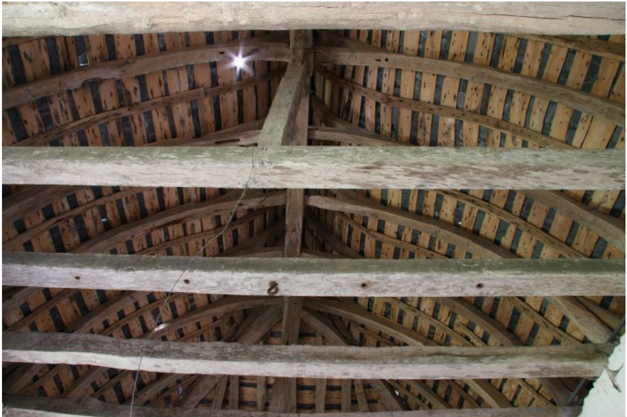
La galerie : charpente à chevron portant ferme.
