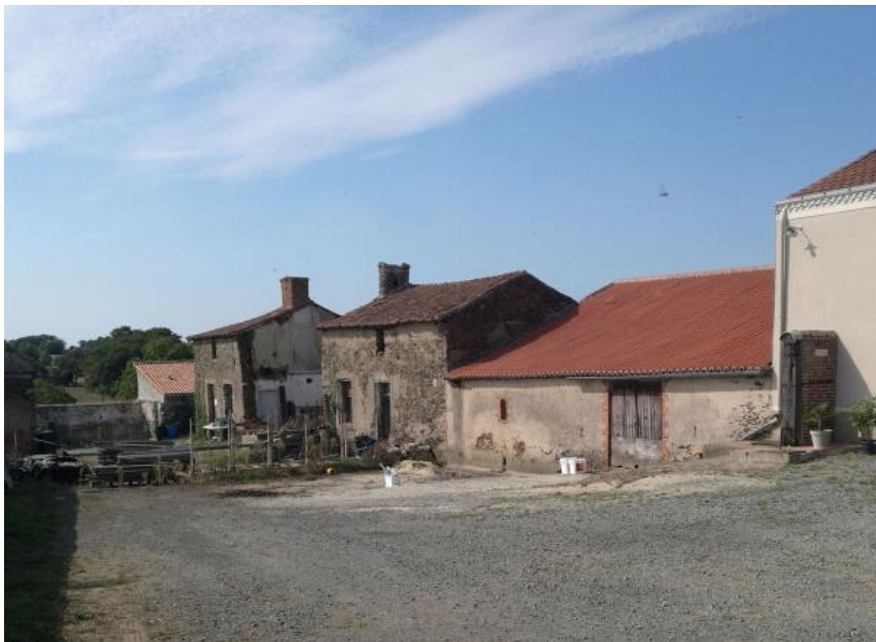
La Bouliverie. Vue d'ensemble.
