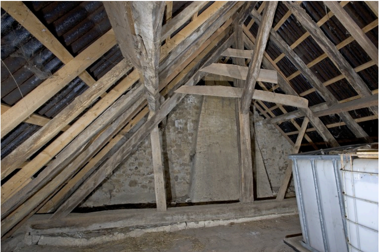
L'ancien logis-étable, charpente : la ferme I vue depuis le nord.
