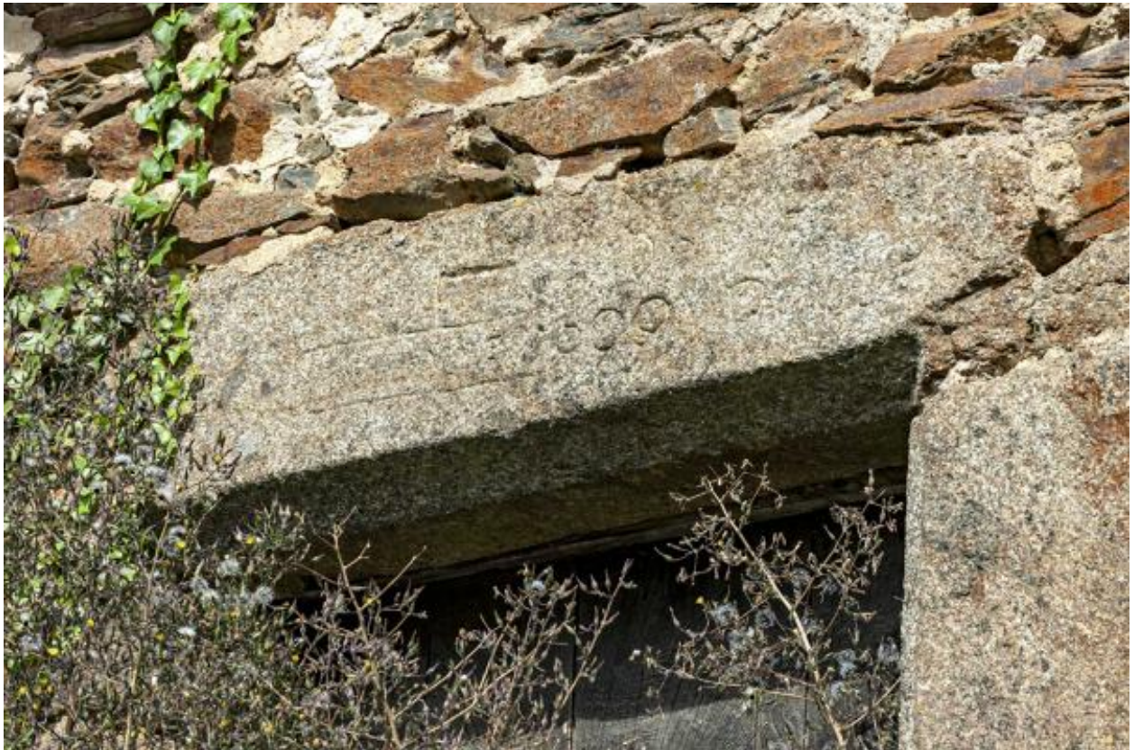
Corps de logis nord, porte droite, linteau portant la date 1609.
