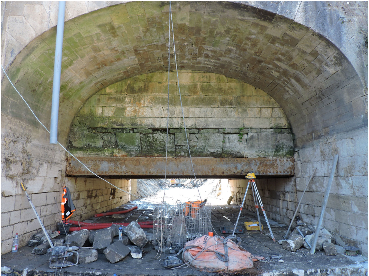
Août 2020 : l'aqueduc vu depuis l'amont, dans le canal de Vix.
