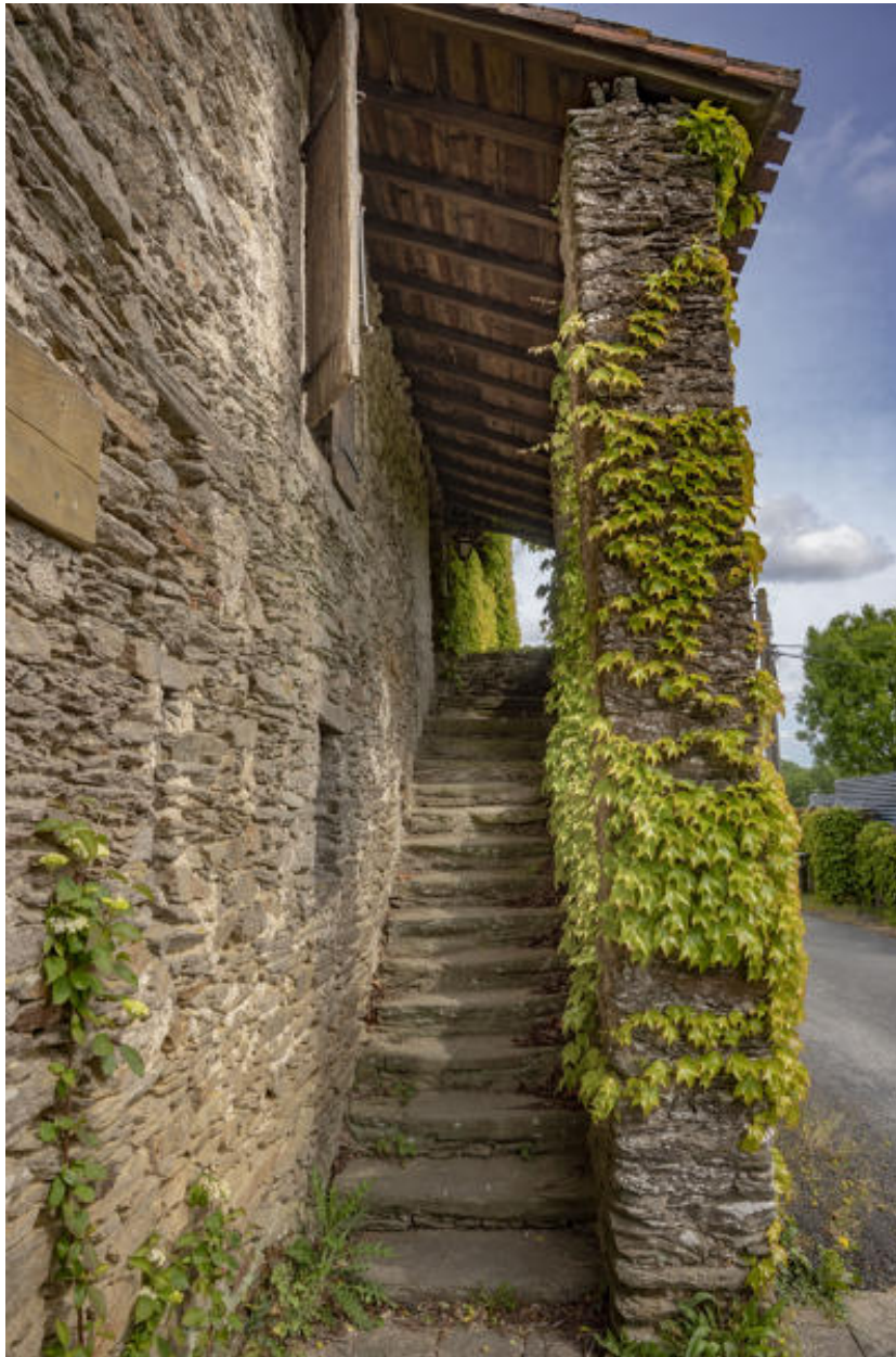
Escalier menant à l'étage d'habitation, en élévation ouest du chai.
