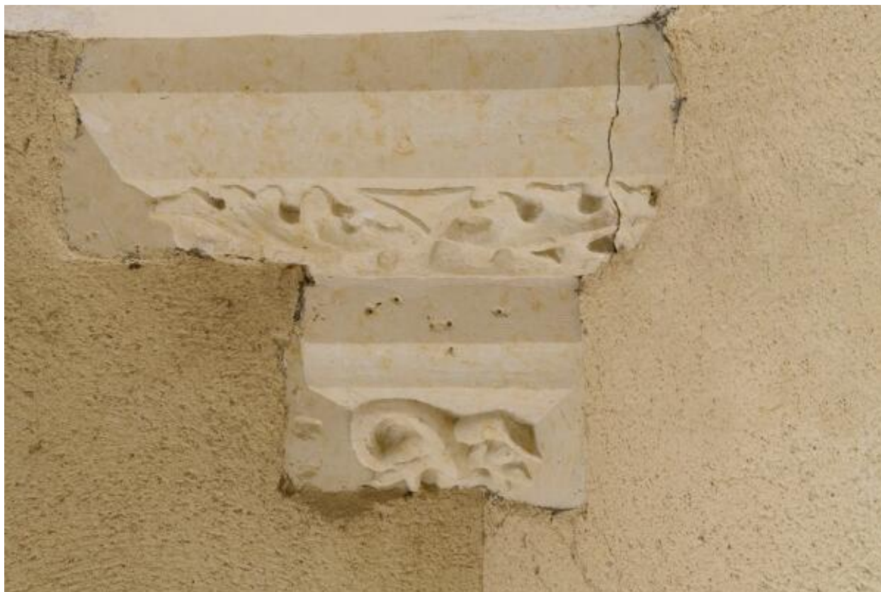
Tour d'escalier. Détail de la sculpture ornant la trompe au-dessus de la porte conduisant à l'ancienne cuisine.
