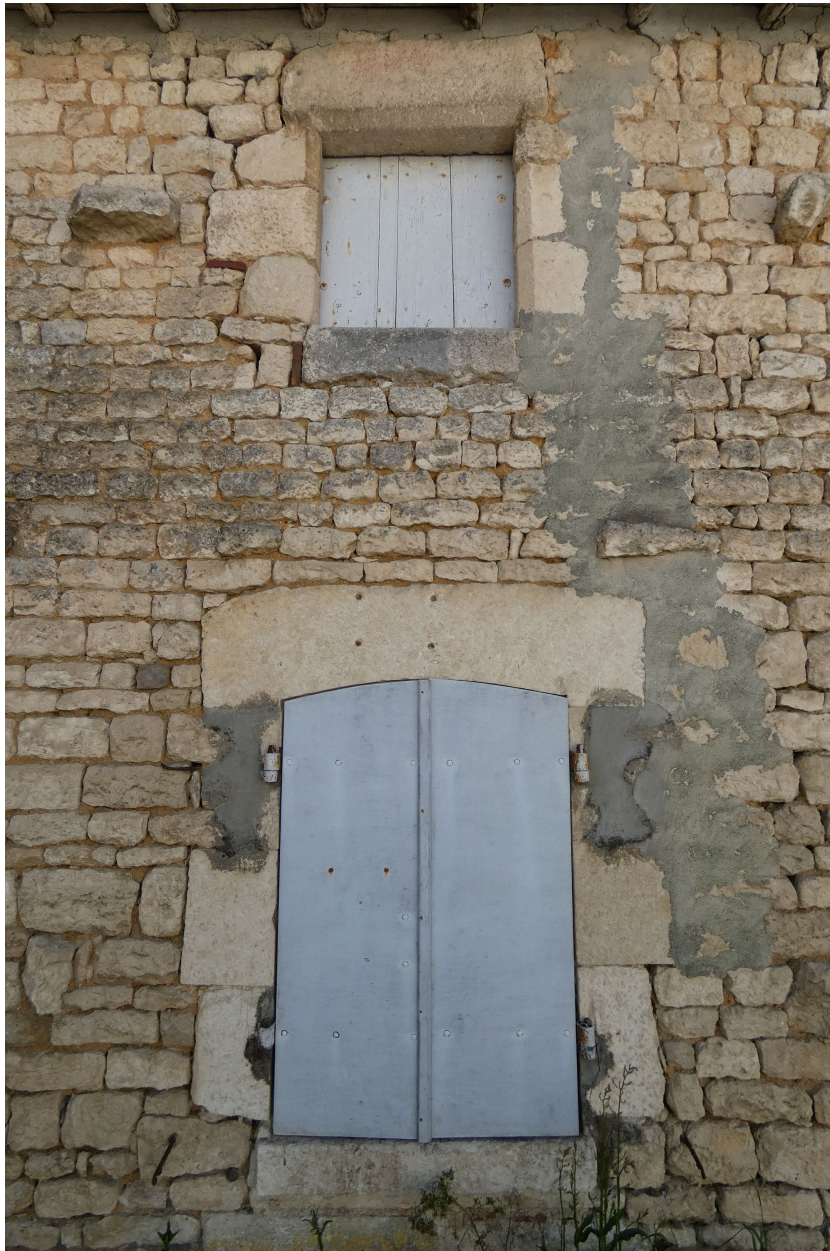
Deux des ouvertures en façade : linteau en arc segmentaire, encadrement chanfreiné.
