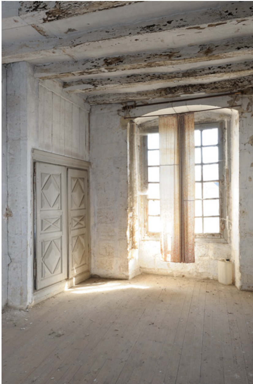
Etage, salle nord. Croisée est et huisseries fermant le cabinet nord.
