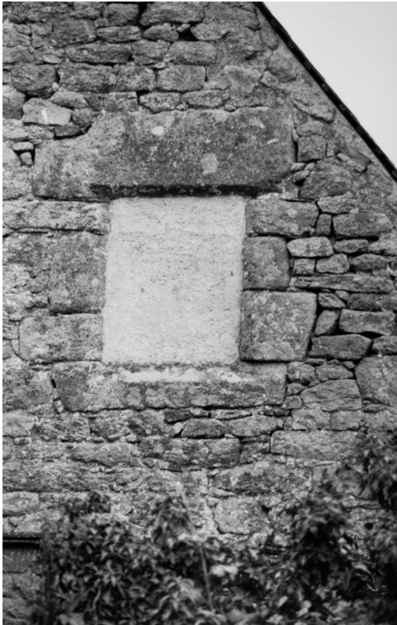
Logis nord. Pignon est. Détail d'une baie, 1990.
