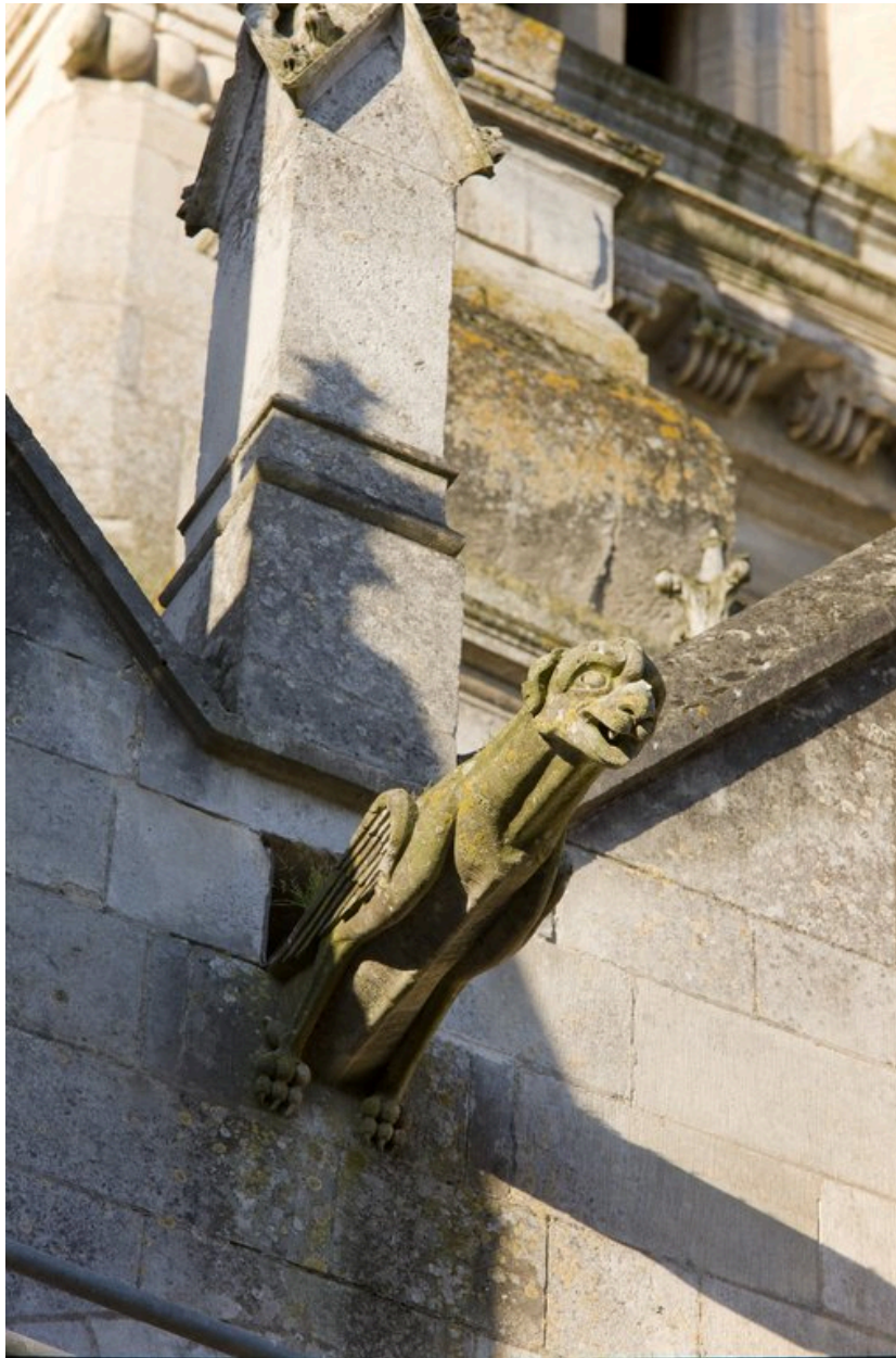
Arc-boutant sur la façade nord du clocher.
