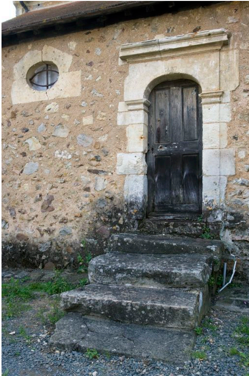
Détail des baies de la sacristie
