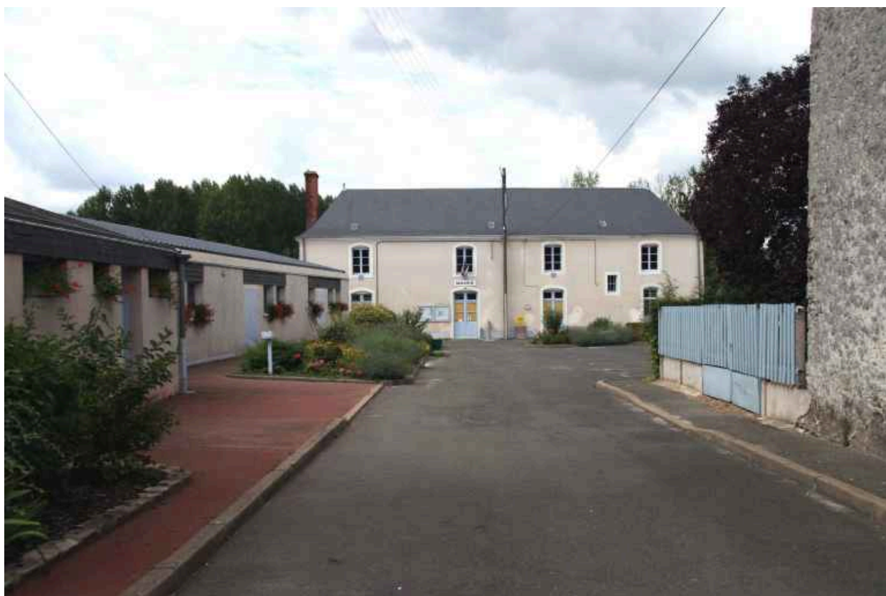
Façade antérieure sur la cour.
