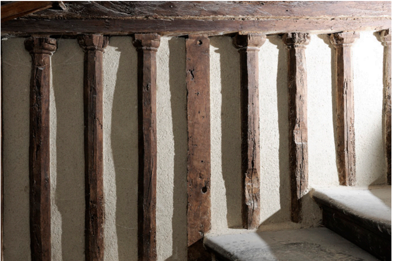
Détail de l'escalier (2).
