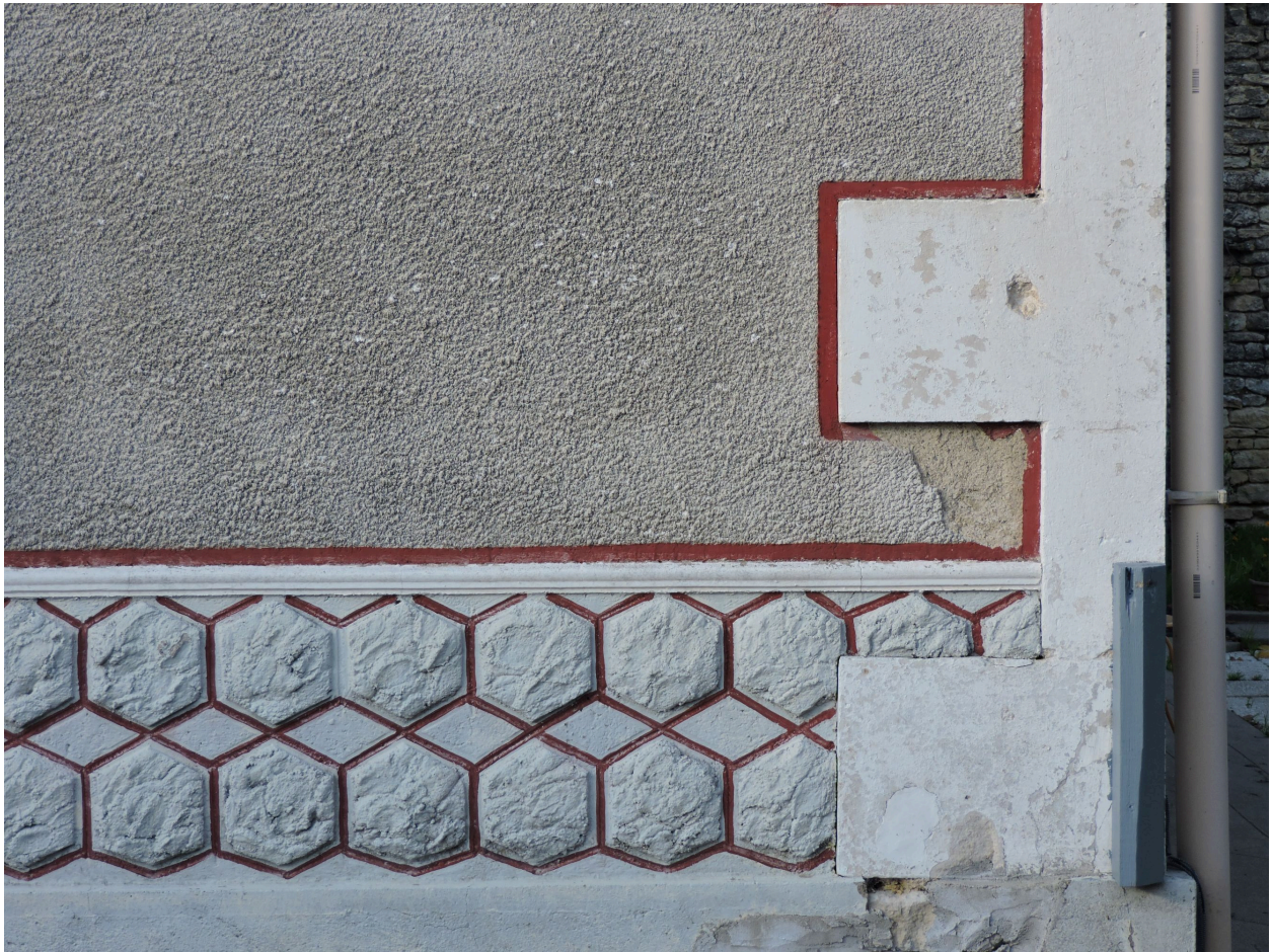
Détail du solin et du décor de la façade.
