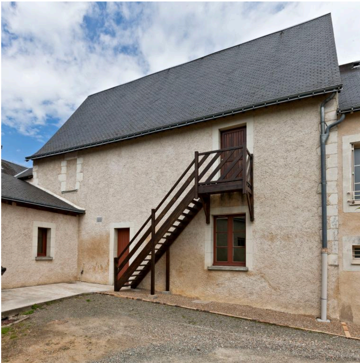
Façade sur cour.
