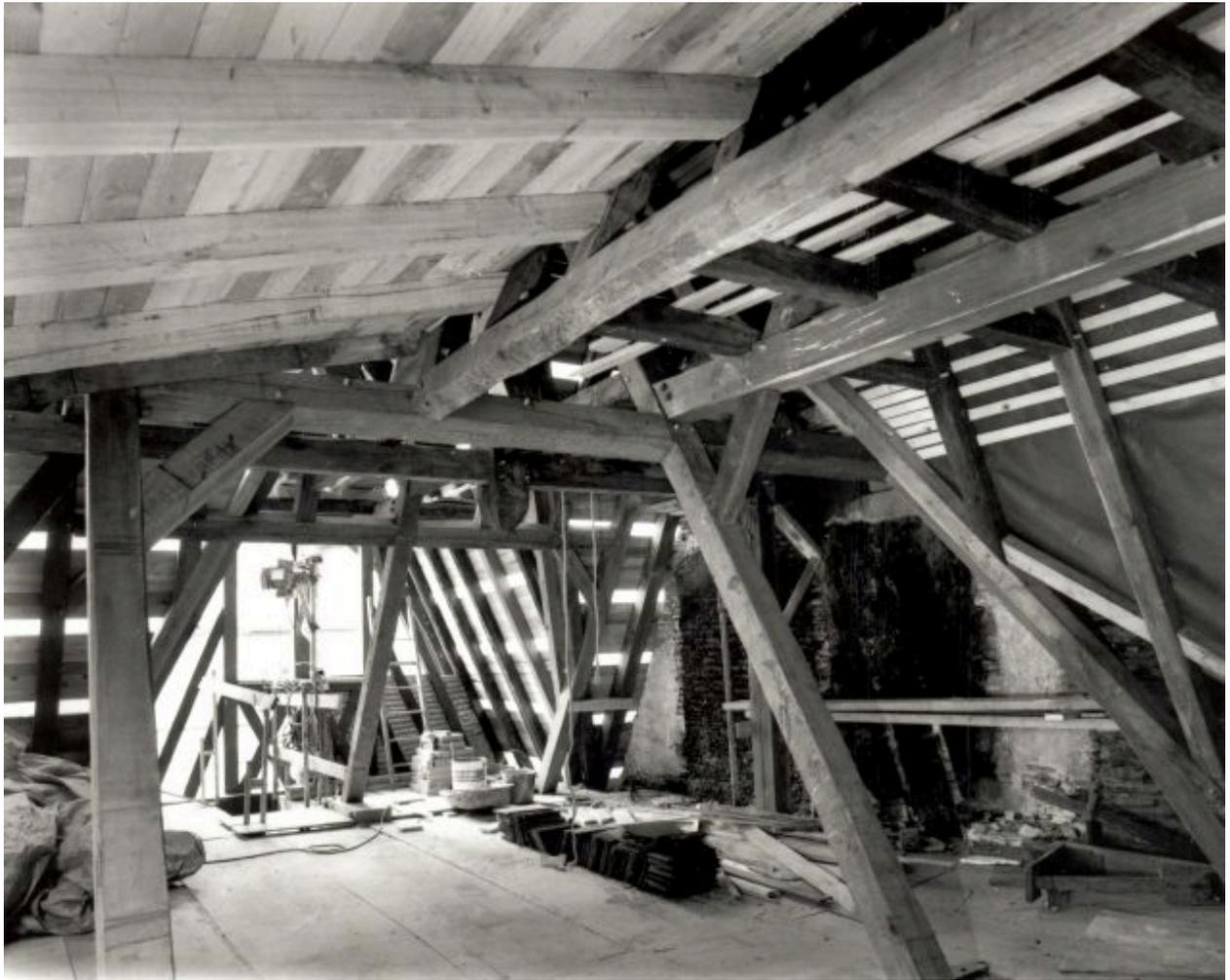
Corps antérieur, 2e niveau de comble : vue longitudinale de la charpente depuis l'angle postérieur droit. Au fond : partie supérieure de la lucarne en cours de restauration.
