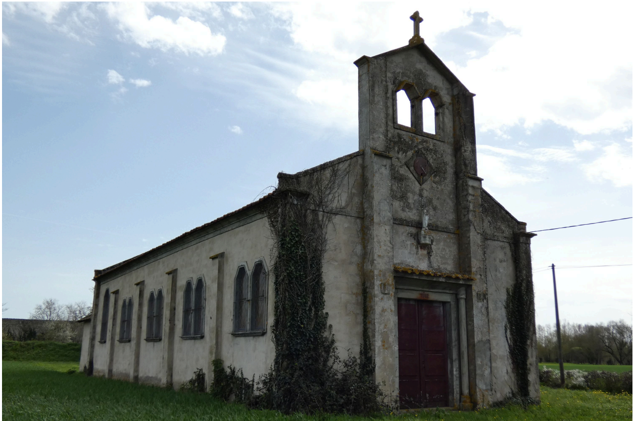
La chapelle vue depuis le nord.
