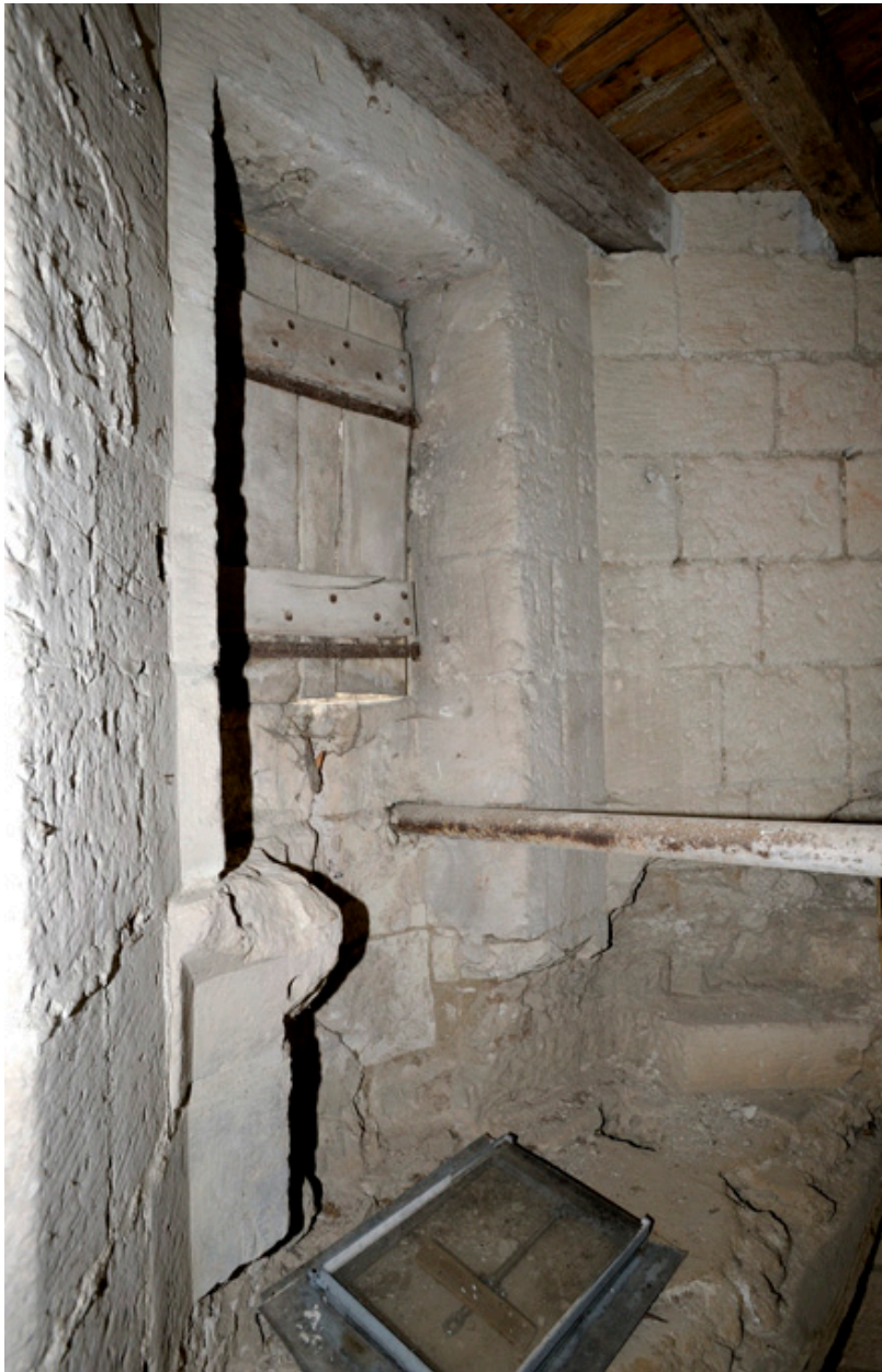
Tourelle d'escalier. Niveau intermédiaire entre l'étage et le comble. Fenêtre à coussiège.
