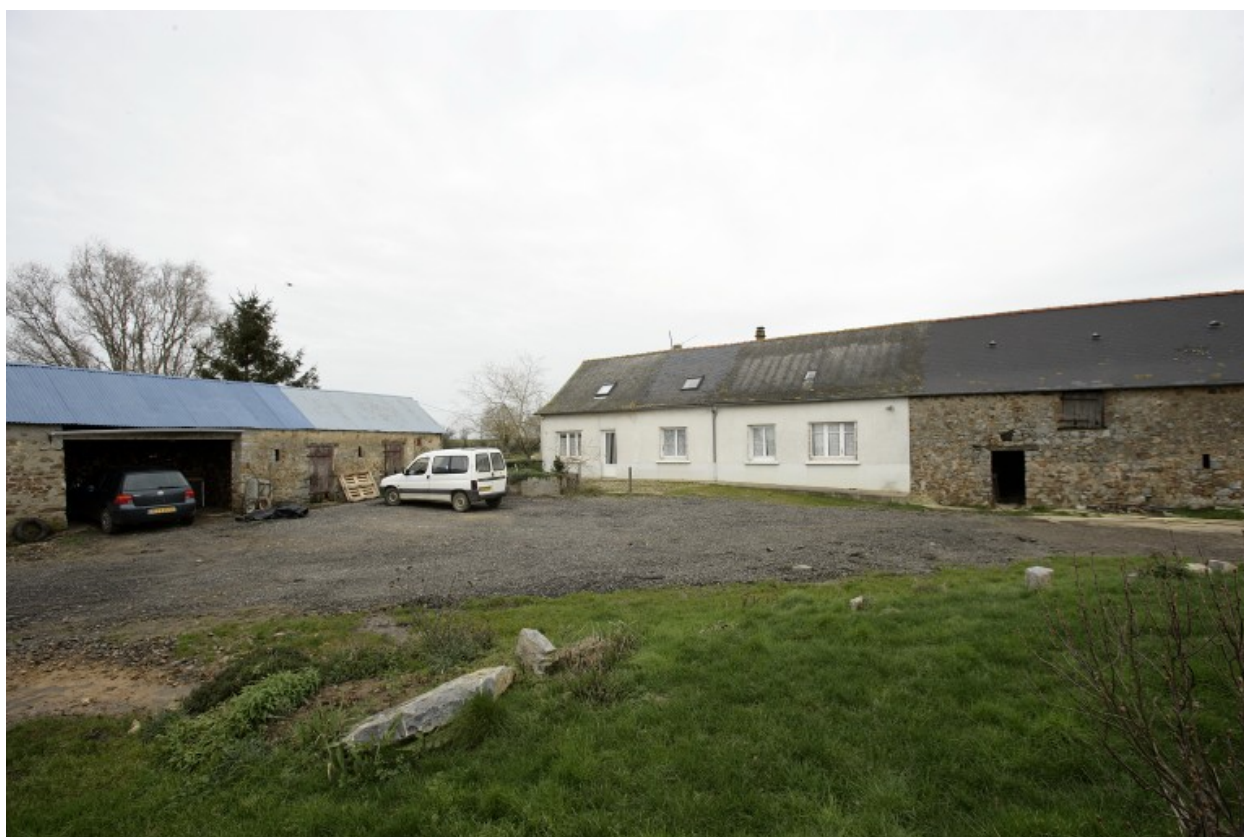
Vue d'ensemble depuis le sud : la porcherie et le logis-étable.
