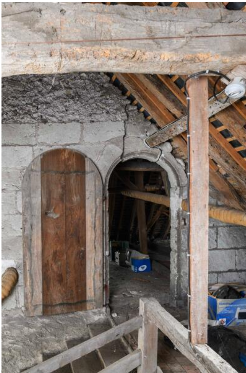
Vue d'ensemble du comble séparé par une baie en arc plein cintre en tuffeau, Petit Château, Montjean-sur-Loire.
