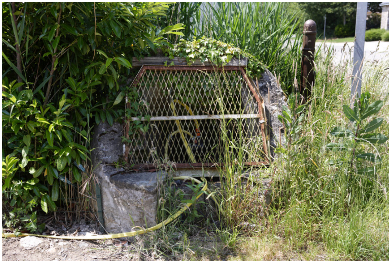
Vue du puits commun.
