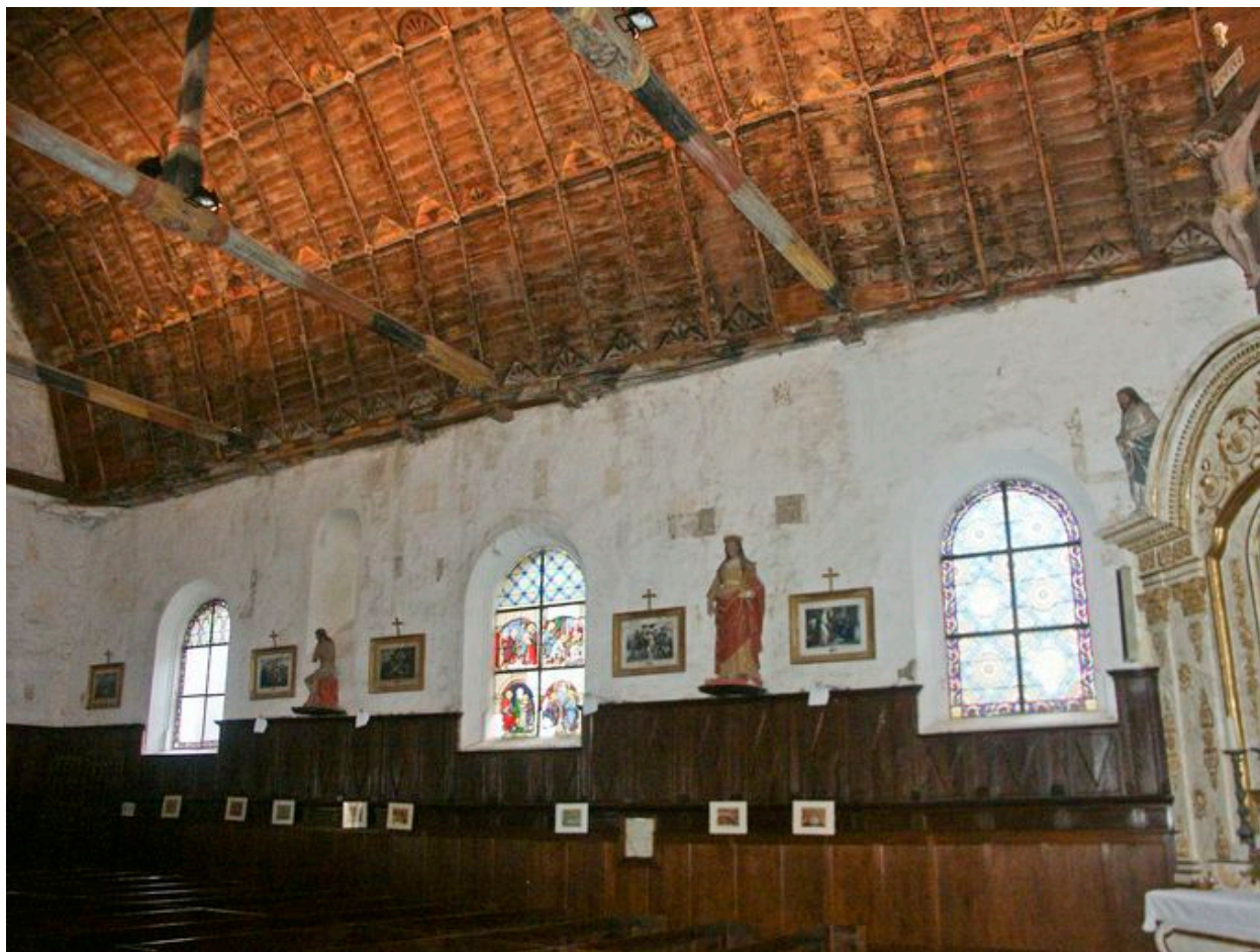
Nef, mur nord : vue d'ensemble des fenêtres de sondage.
