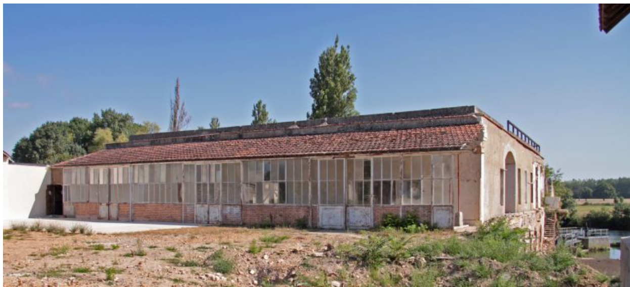
Façade latérale du bâtiment principal, galerie de circulation.
