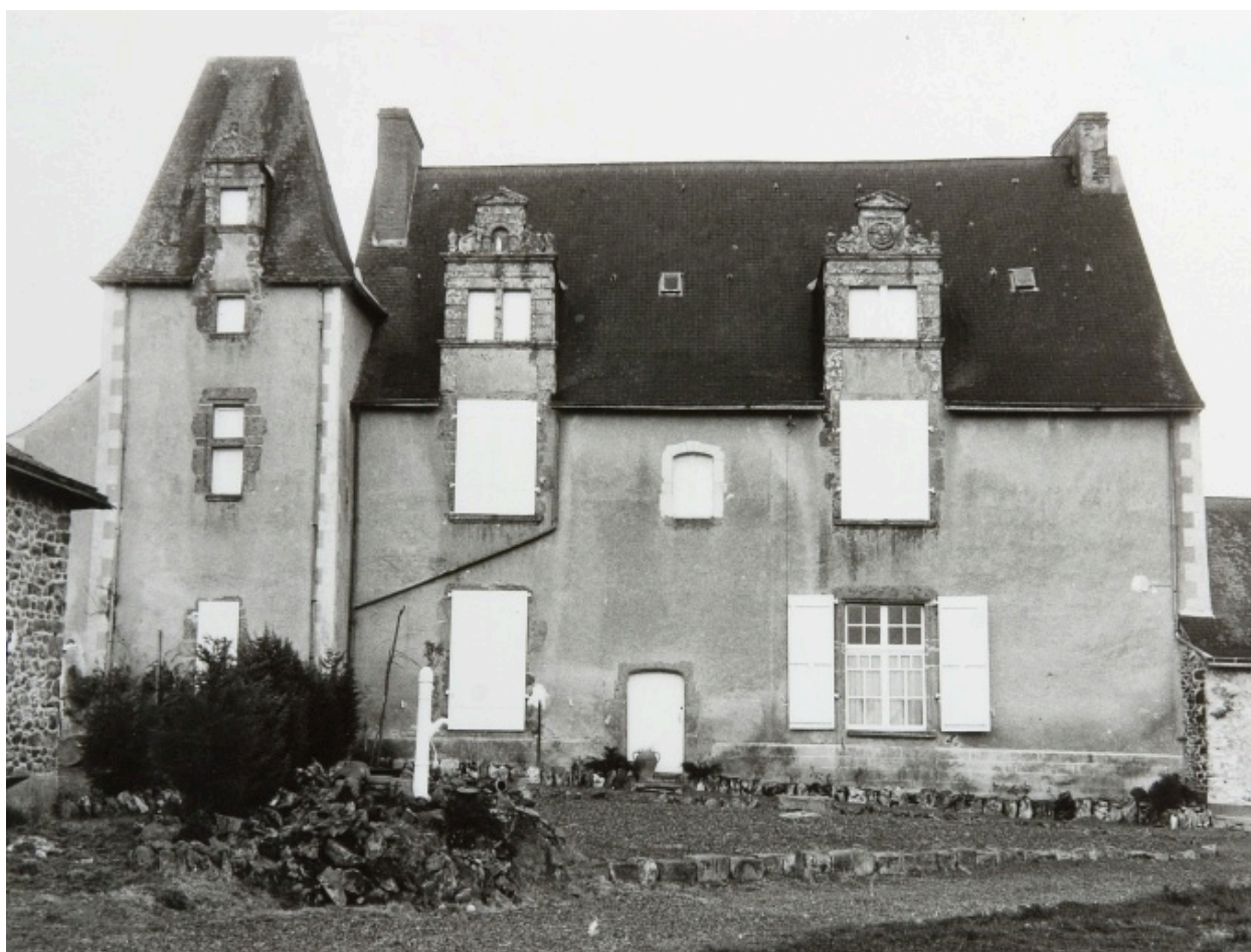
Photographie, 1968. L'élévation principale du logis.
