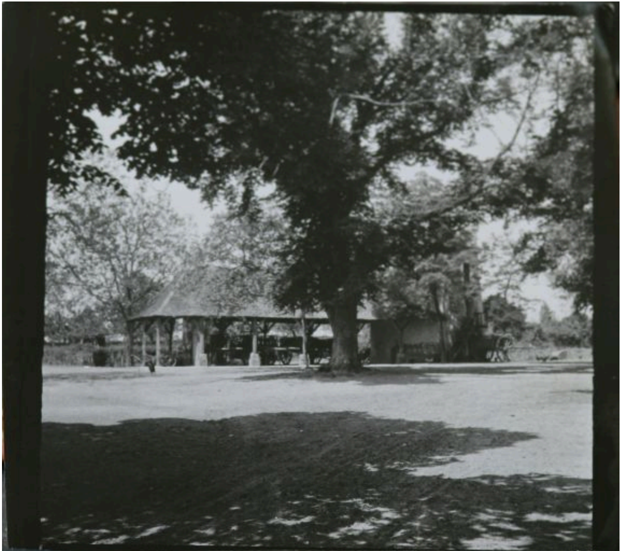
La basse-cour du château : le pigeonnier et le hangar. Photographie (collection particulière).
