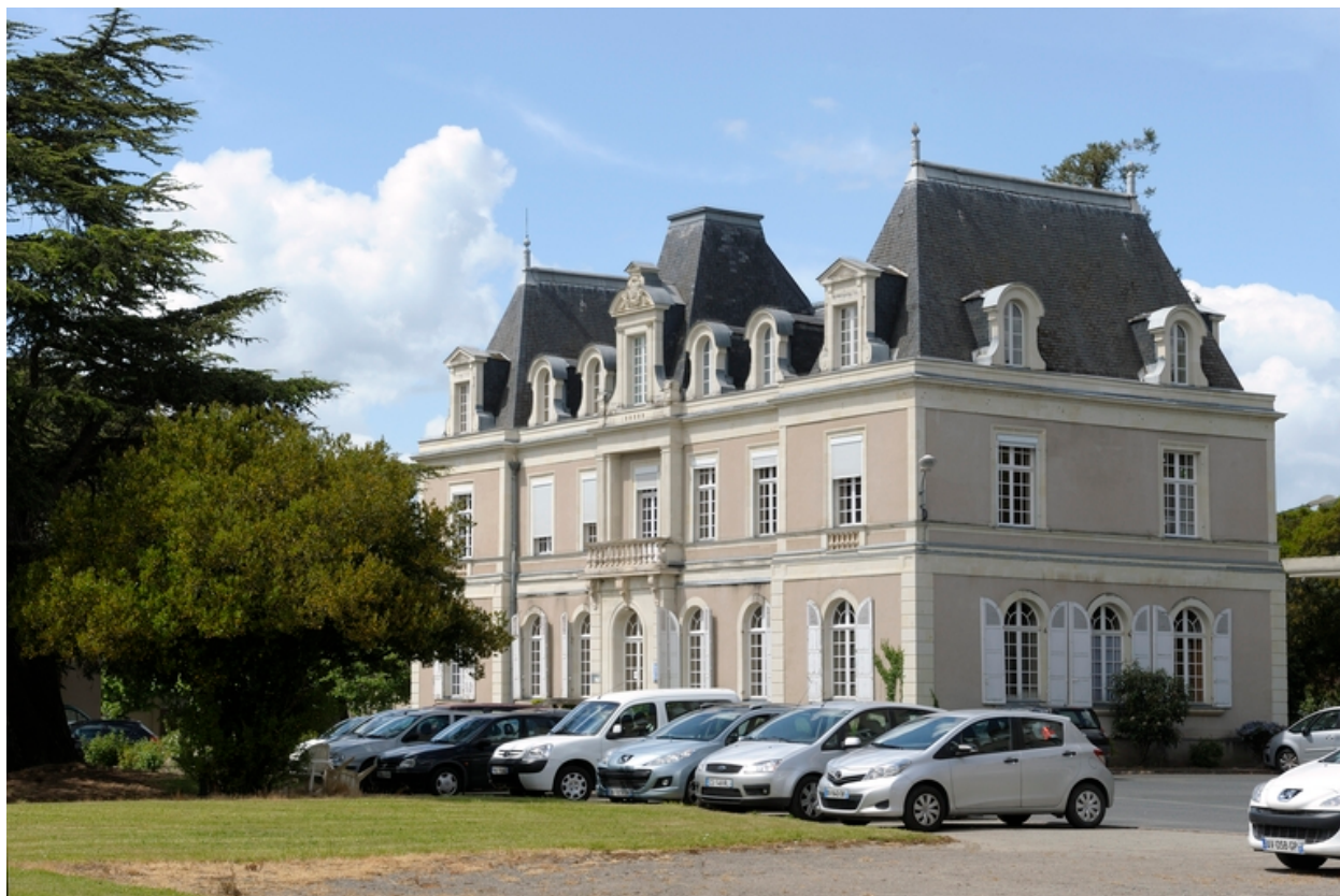
Vue du château depuis le sud-est.
