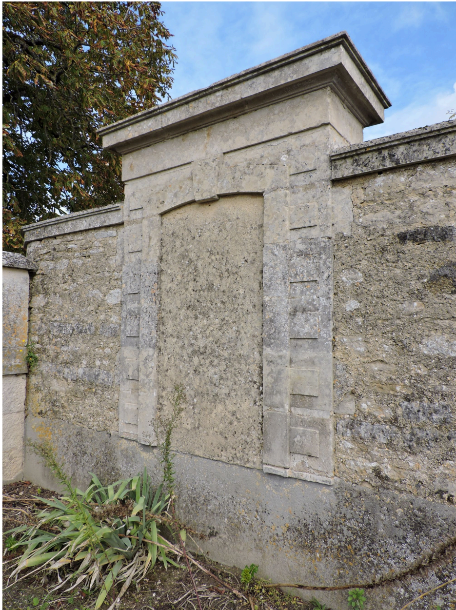
La fenêtre murée donnant sur le calvaire, en retour d'angle du portail.
