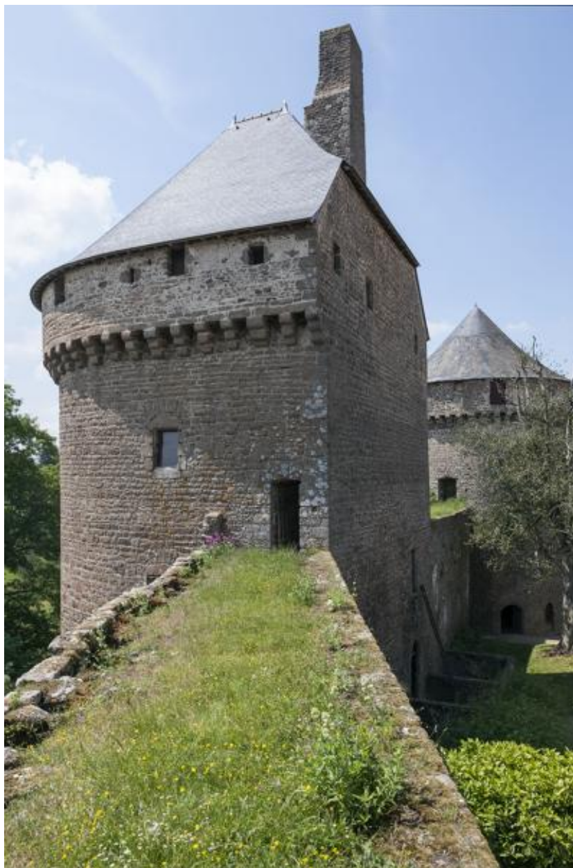
Tours 5 et 6, vues depuis la courtine.
